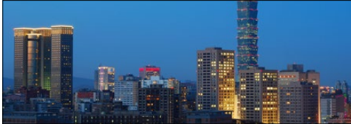
스마트 시티(HVAC, 조명, 전력 모니터링/미터링, 주차 미터기)
