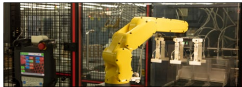
IoT เชิงอุตสาหกรรม / หุ่นยนต์และระบบอัตโนมัติในโรงงาน
